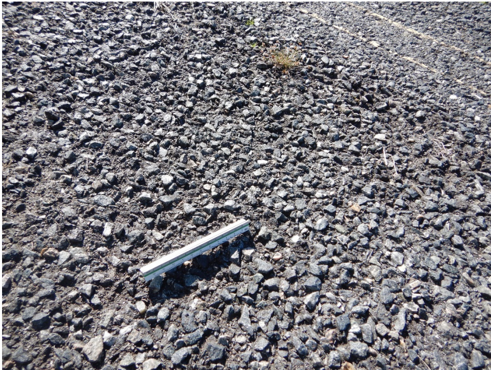
A02BT-10. Raveling (Sample Unit No. 46) (1).
