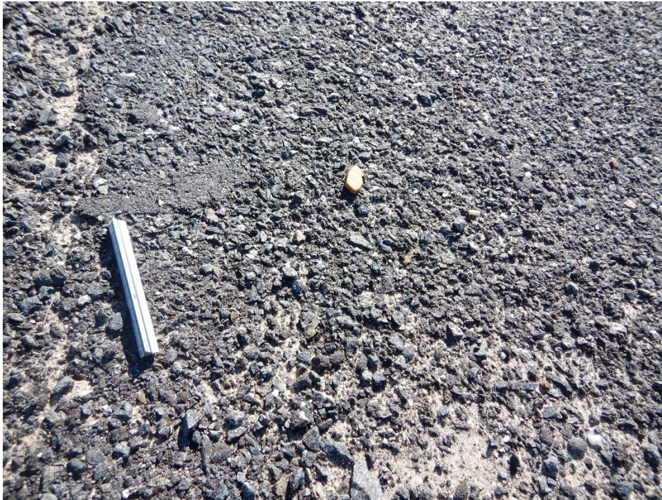
A02BT-10. Raveling (Sample Unit No. 46) (2).
