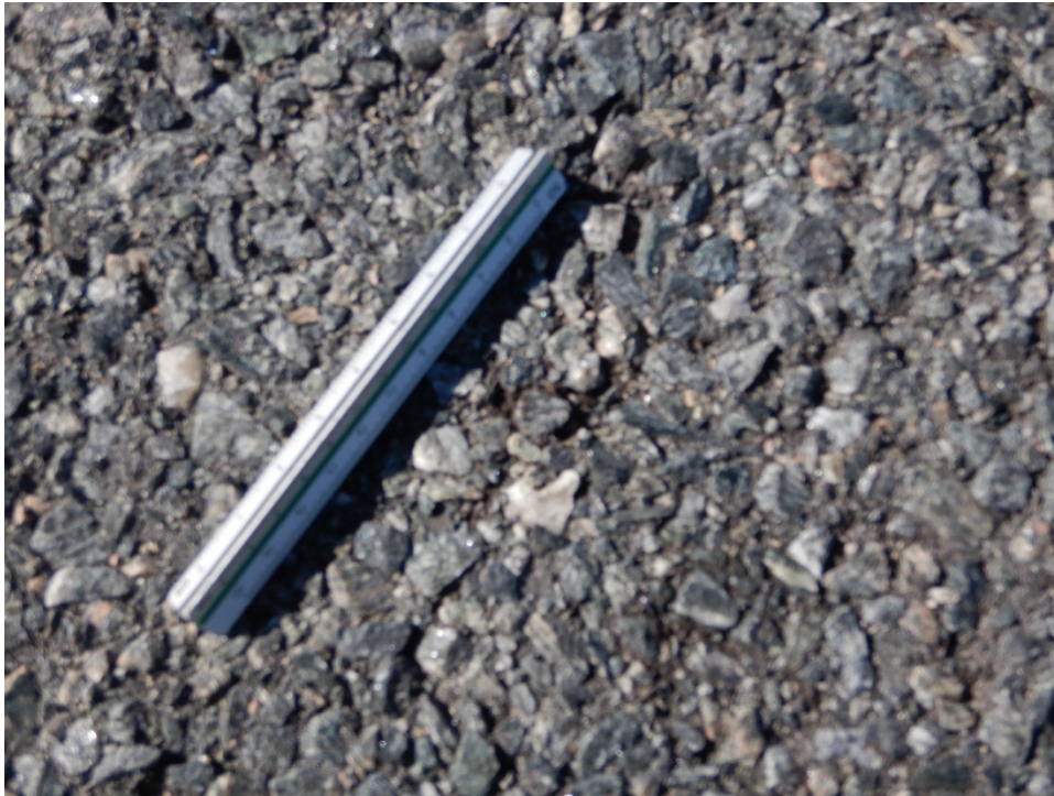
R119BT-10. Weathering (Sample Unit No. 08).
